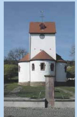
Ev. Kirche Böckweiler
